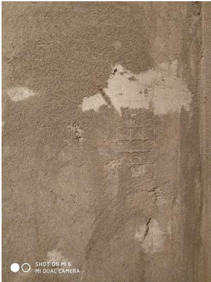
▲已经上墙的钢丝网，能看到钢丝网和水泥不是层次分明的，是互相结合的，就像钢筋混凝土都是钢筋穿插在混凝土里，这样强度才够
